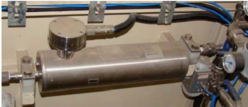
图 4：流量传感器现场安装图片
